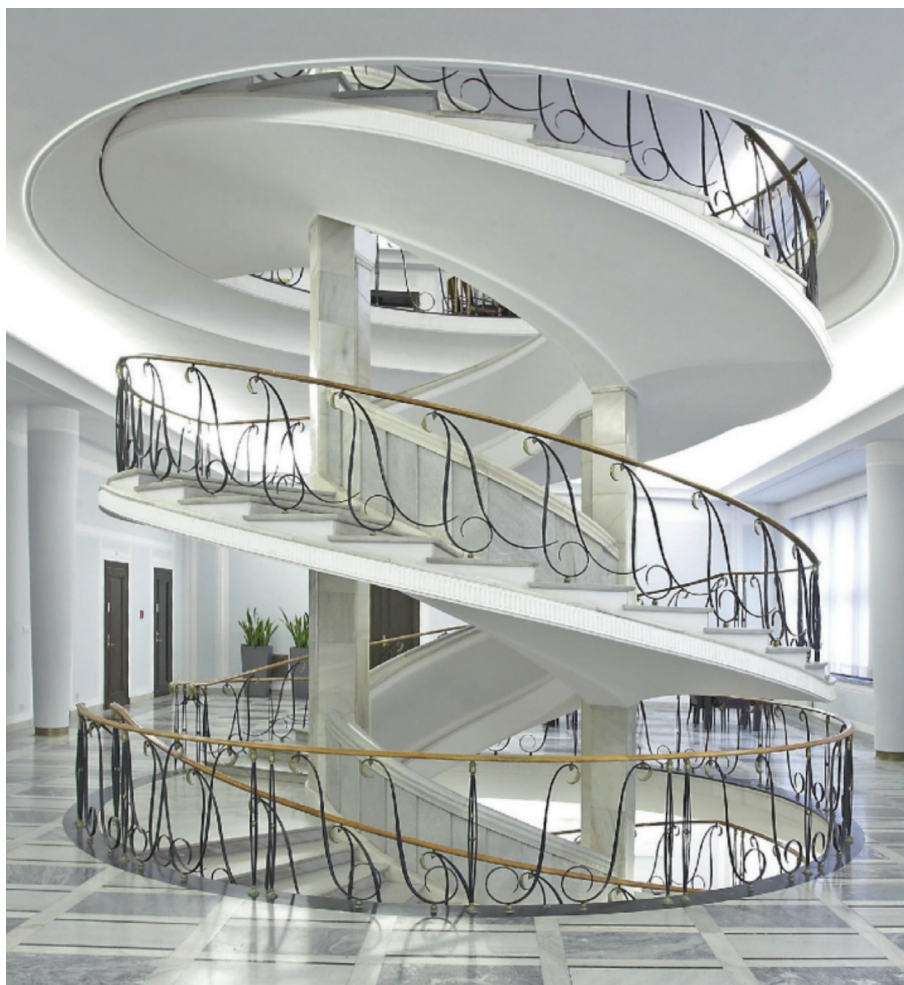
Fot. 7. Owalna klatka schodowa w bud. A
